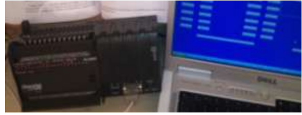
Figura 7 Interfaz en comunicación con el PLC.
